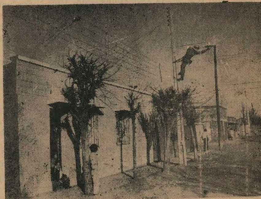
En Santiago se reemplazan las ampolletas incandescentes por lámparas de mercurio. En el grabado, trabajos en la comuna de Renca.
